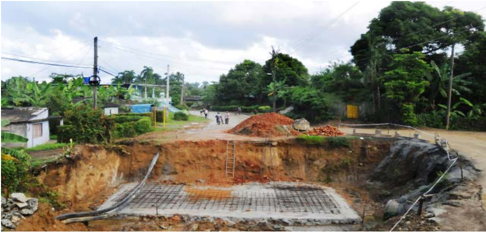
Los constructores trabajan con una programación actualizada para concluir la reparación a fines de este año. En la imagen, cimentación de la base del estribo I (Baracoa).
