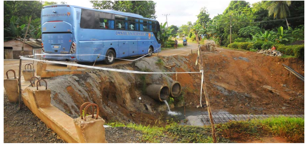
Desde el inicio de la obra en abril del año pasado se emplea un desvío contiguo.
