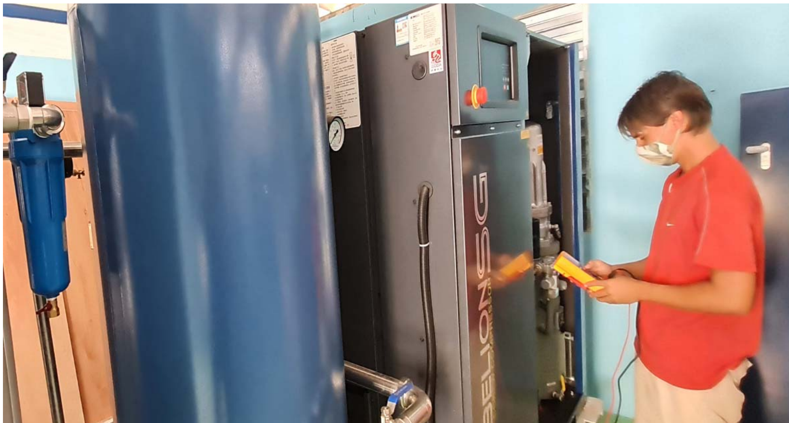
El técnico del Cedai comprueba la instalación de los motores de una de las plantas.
