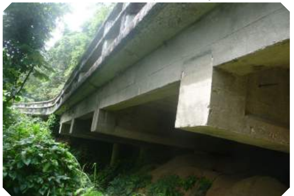
Ingeniosidad en las soluciones técnicas. Obsérvense los gruesos pilotes encajados sobre la roca y las vigas de hormigón de alta resistencia, donde descansa la placa volada sobre el precipicio. (Foto: J. L. M. C.)
