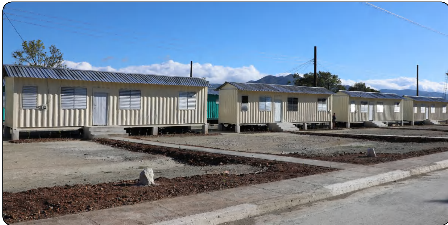
La novedosa barriada de casas contenedores en la comunidad de Buena Vista, San Antonio del Sur.
