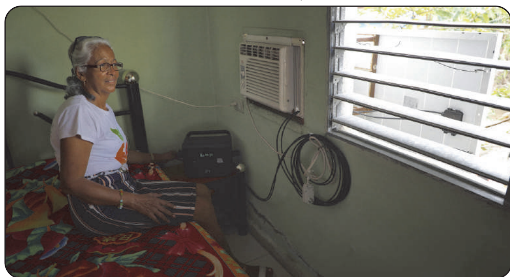
Mairelis agradece este bien que llega para paliar la tensa situación eléctrica.
