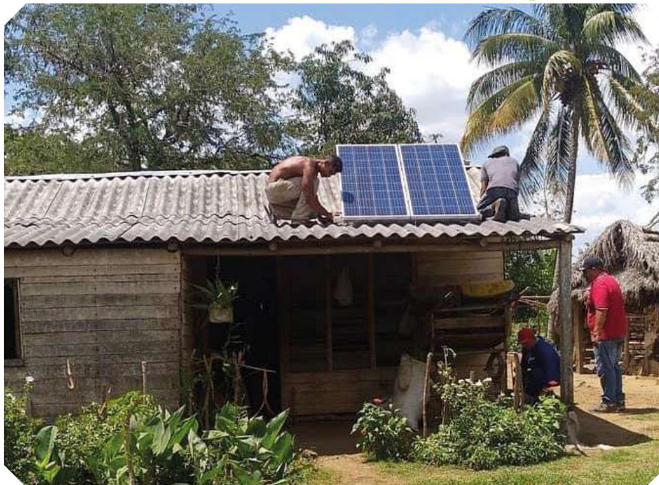
La provincia colocará sistemas completos de 2 kWp en 360 viviendas aisladas.
